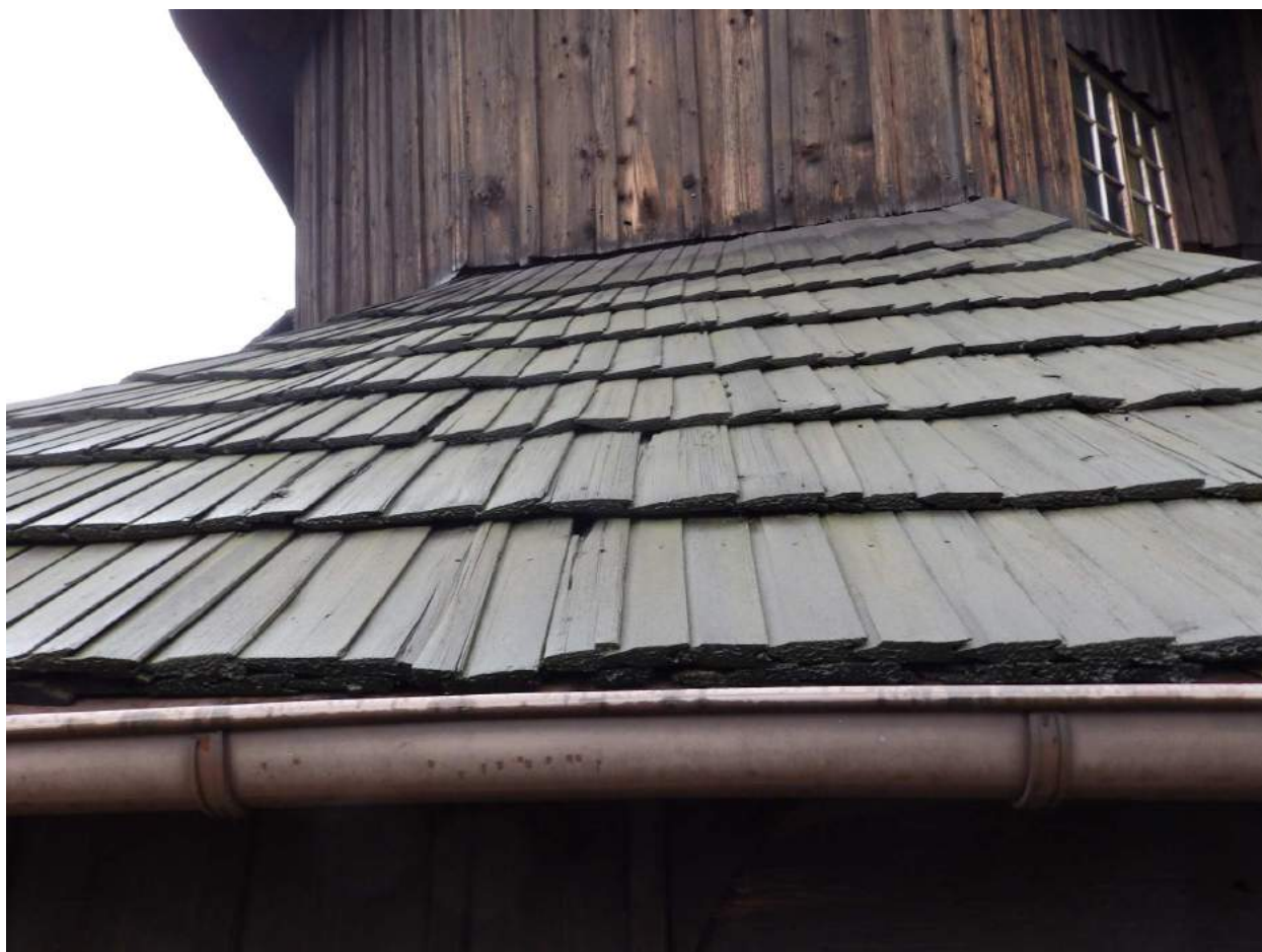
Fot.12 Pokrycie dachowe nad sobotami
