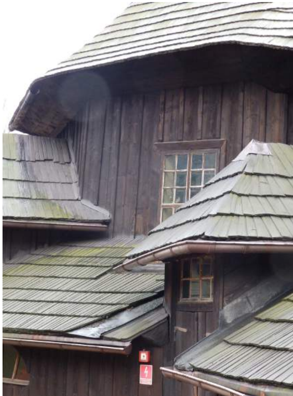
Fot. 1 Glony i porosty na pokryciu od strony północnej
