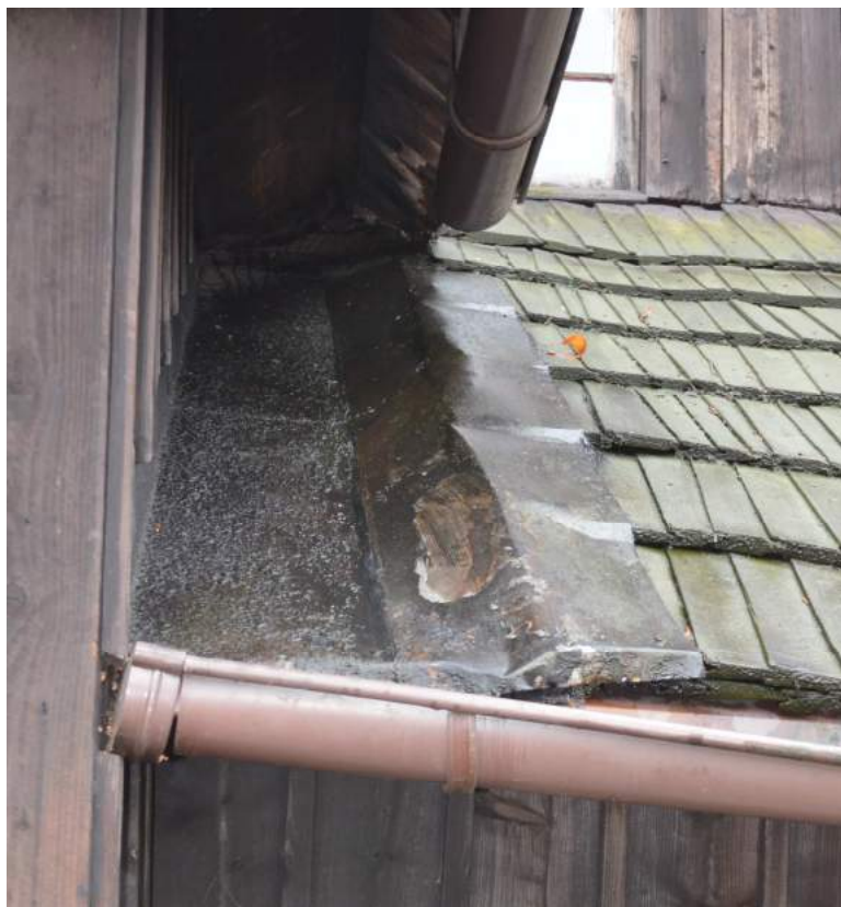
Fot. 10 Obróbka blacharska przy wejściu do sobót
