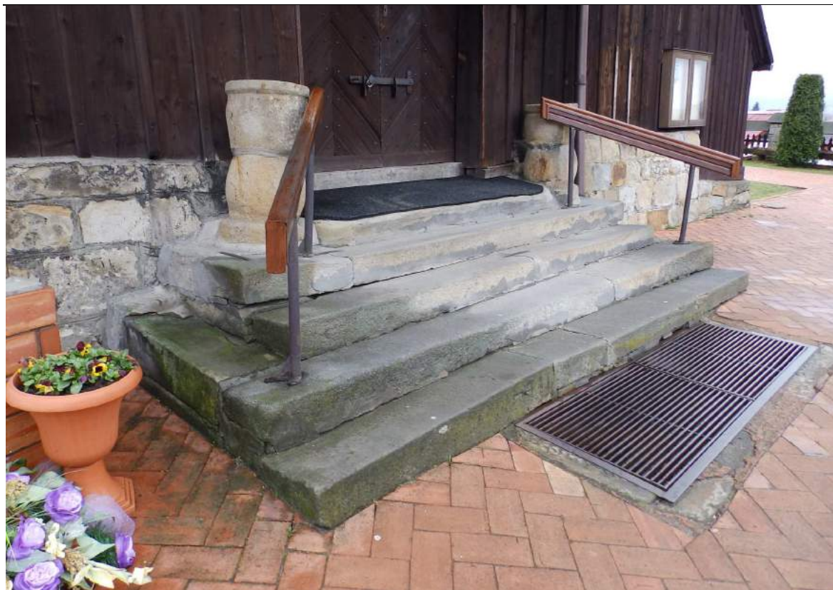
Fot.13 Kamienne schody przy wejściu do kruchty
