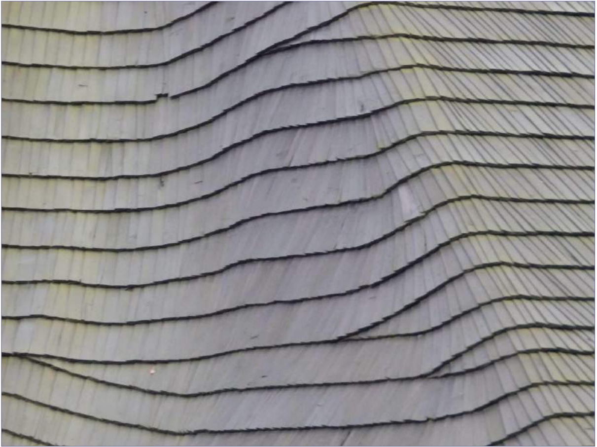
uszkodzenia gontów - spękania, ubytki, wylamanie, wypadanie deseczek
