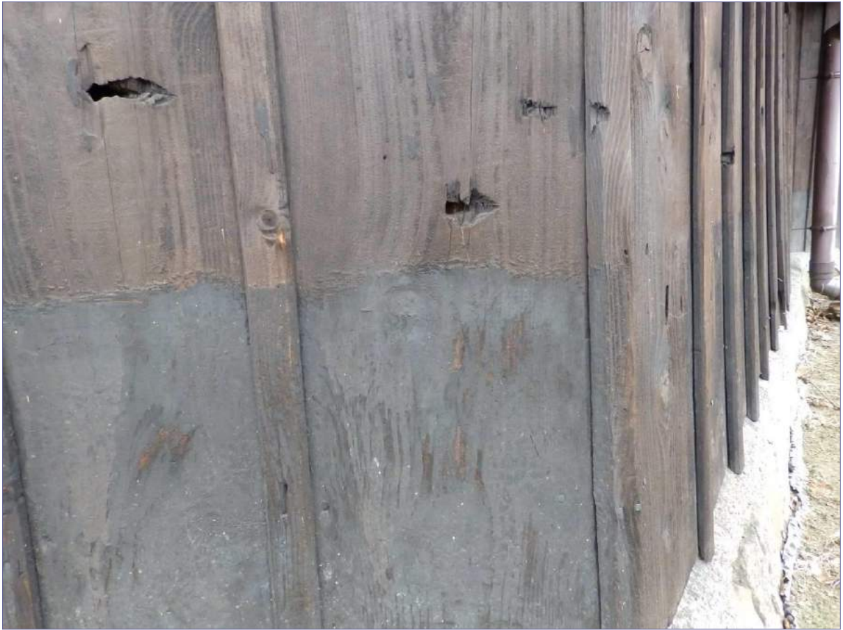
przemalowanie dolnych partii desek szalunkowych farbą w tonacji szarawej, widoczne jej złuszczenia; drzwi bez klamek i listwy przymykowej, podmurówka w górnej części zatynkowana sztywną zaprawą cementową, zniszczone rury plastikowe i rynny, odbarwienia
