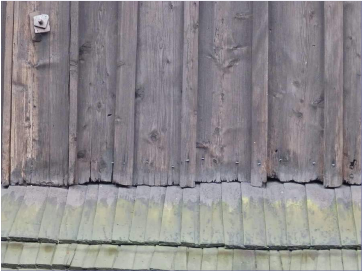
uszkodzenia dolnych fragmentów desek szalunku, wylamane listwy, zardzewiałe gwoździe kute, znaczne wyjąłowanie drewna, widoczne otwory po owadach szkodnikach, spękania i wyszczerbienia
