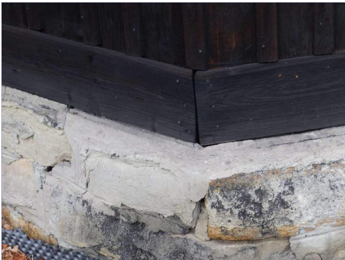
uszkodzenia dolnych fragmentów desek szalunku elewacji, zróżnicowana w budowie i charakterze podmurówka, liczne uzupełnienia cementem, przebarwienia i zabrudzenie zaprawami, farbami itp.
