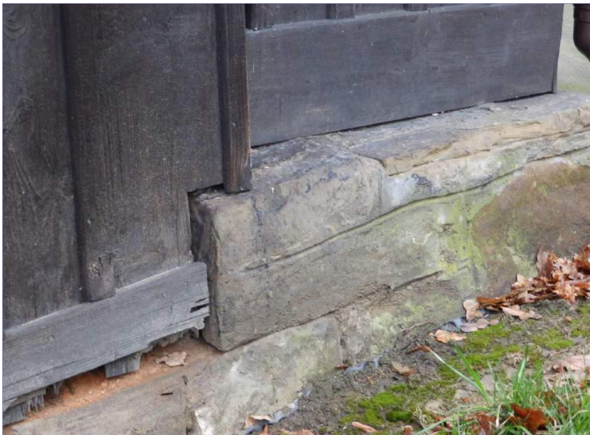
uszkodzenia dolnych fragmentów desek szalunku elewacji, zróżnicowana w budowie i charakterze podmurówka, liczne uzupełnienia cementem, przebarwienia i zabrudzenie zaprawami, farbami itp.
