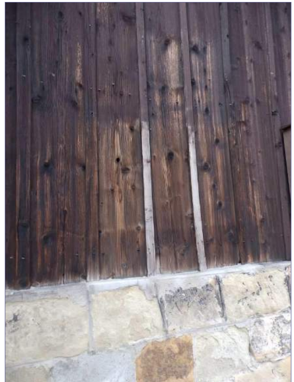
uszkodzenia dolnych fragmentów desek szalunku, wylamane listwy, zardzewiałe gwoździe kute, wyjąłowanie drewna, wyszczerbienia; widoczne otwory po owadach szkodnikach a także większe spowodowane przez gryzonie i ptaki; wypłukanie barwników, przebarwienia i spękania
