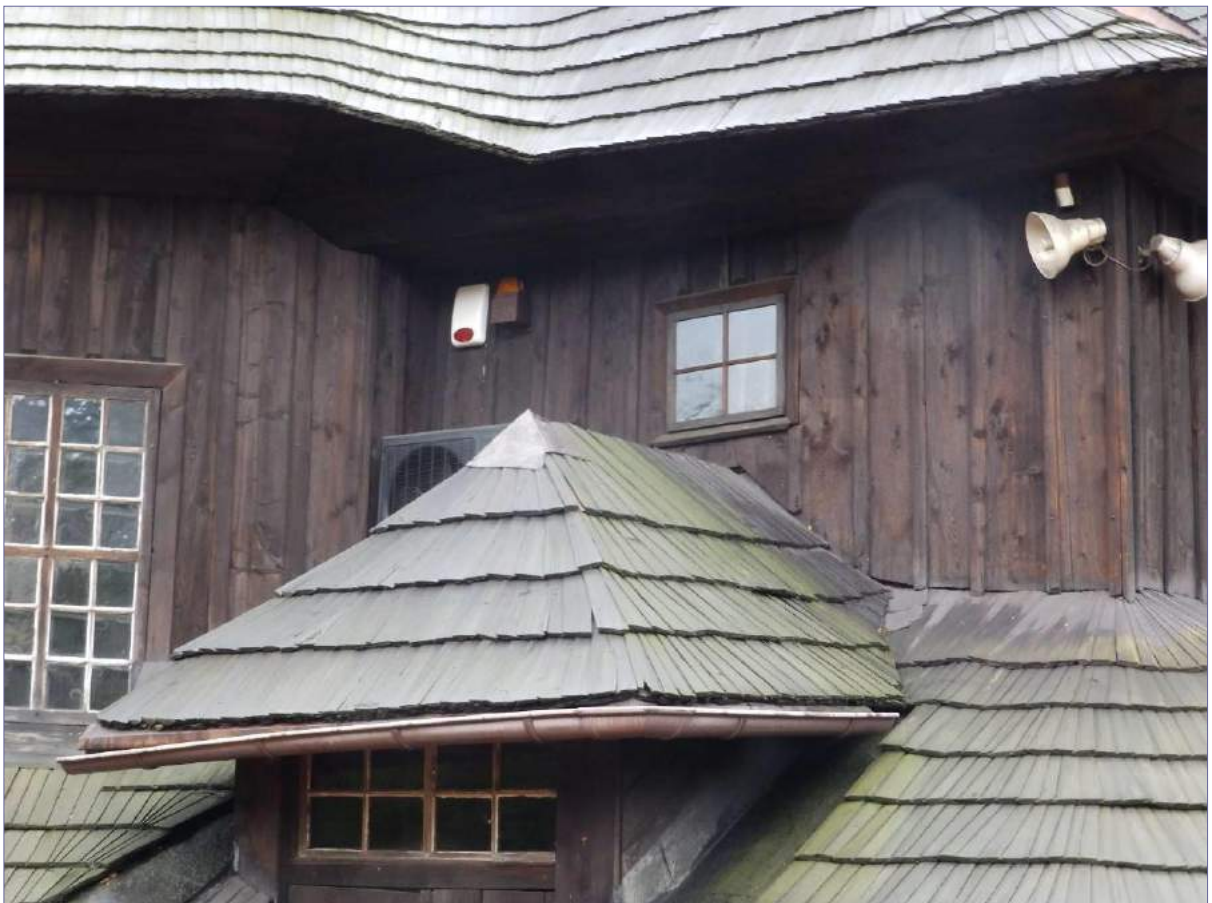
uszkodzenia deski poziomej nad podmurówką, pod spodem zniszczenia szerokich desek szalunkowych; przebarwienie, wysolenia, zgrzybienie; widoczne wystające fragmenty izolacji folii kubelkowej; zniszczenia gontu, doraźne zabezpieczenia blachą daszku, nowsze okienko kwadratowe
