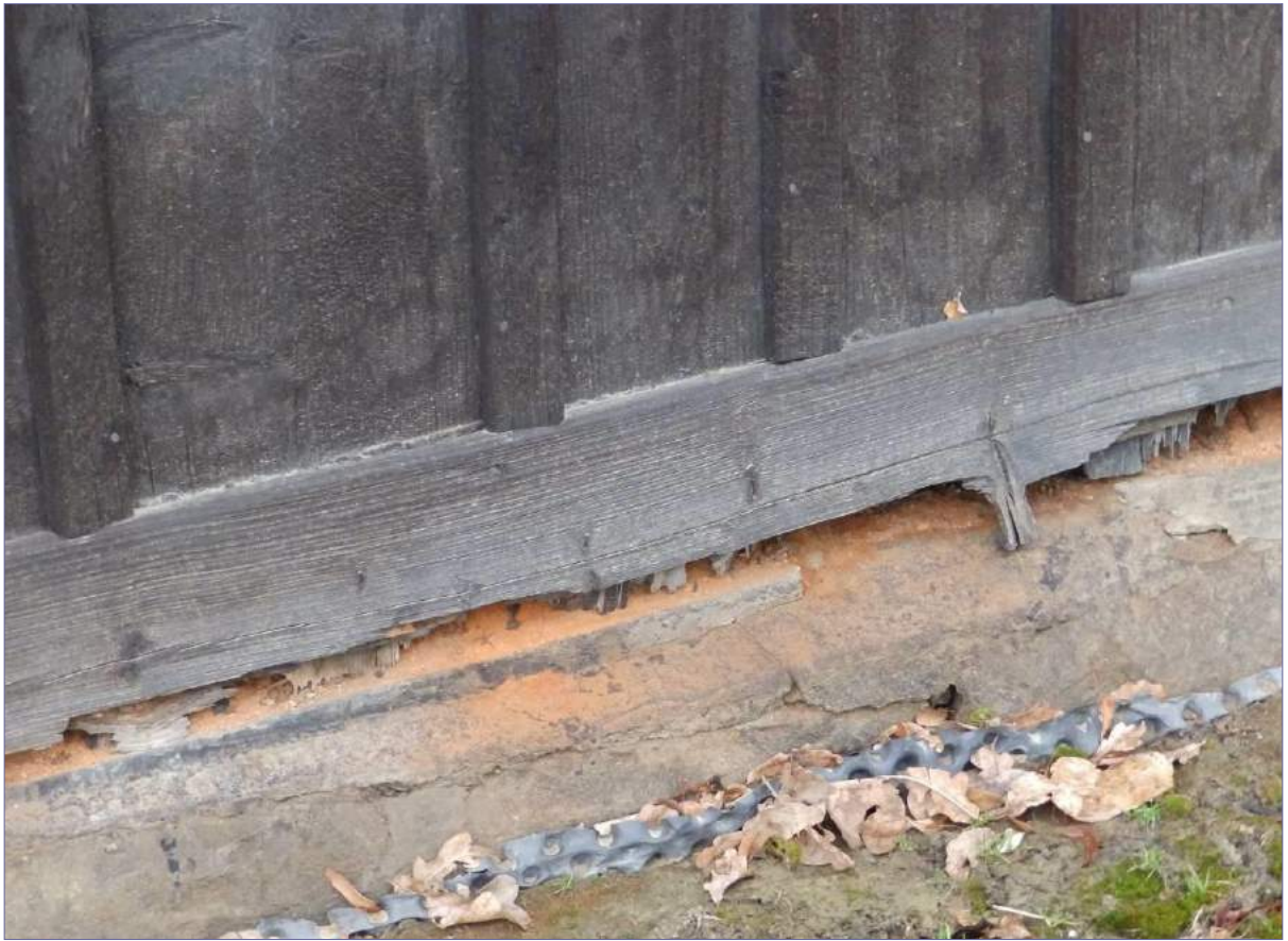
znaczna degradacja drewna elewacji- uszkodzenia deski poziomej nad cementową podmurówką, pod spodem zniszczenia szerokich desek szalunkowych; przebarwienie, wysolenia, zgrzybienie; widoczne wystające fragmenty izolacji folii kubelkowej
