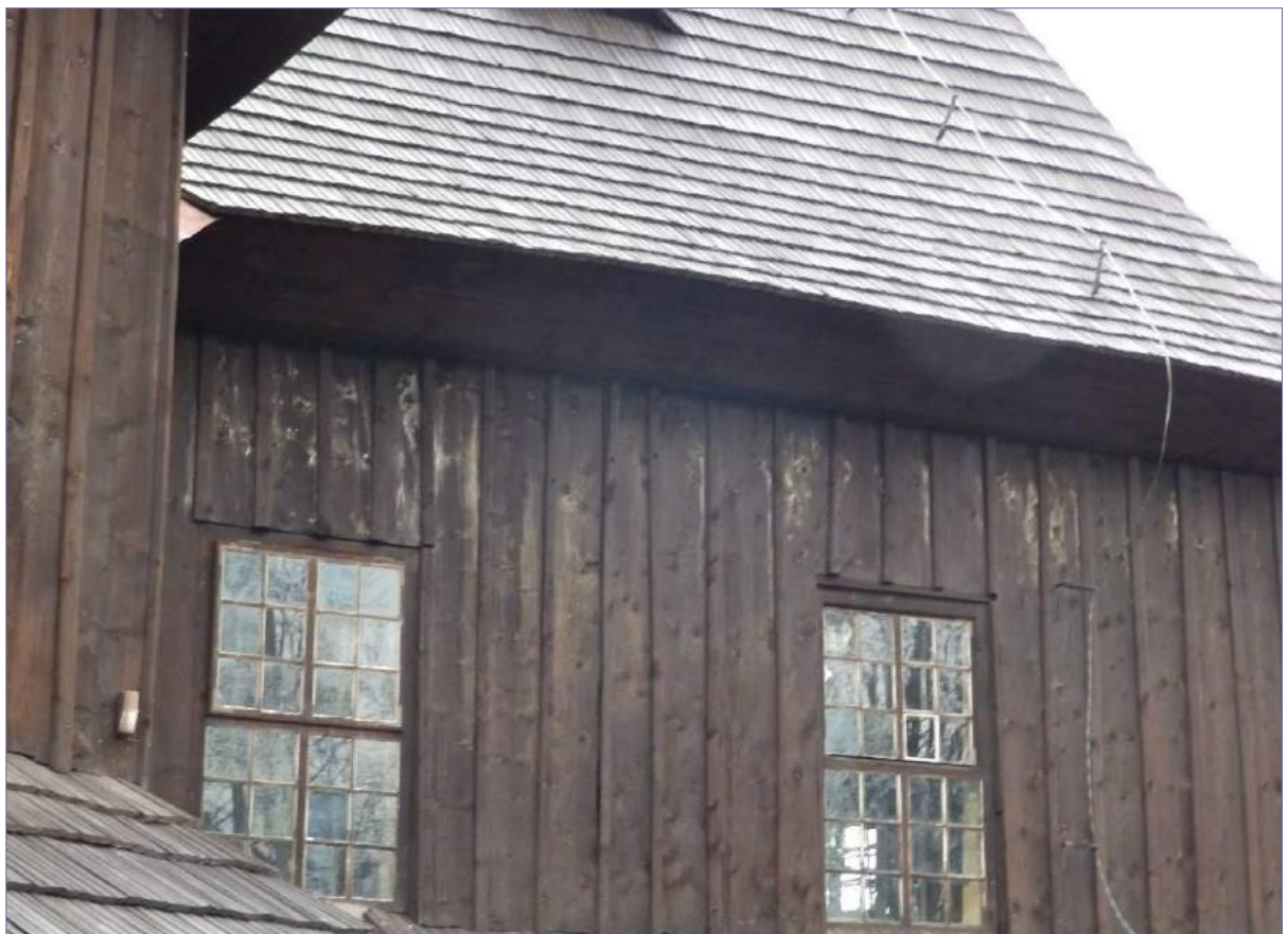
znaczna degradacja drewna elewacji- uszkodzenia deski poziomej nad cementową podmurówką, pod spodem zniszczenia szerokich desek szalunkowych; przebarwienie, wysolenia, zgrzybienie; widoczne wystające fragmenty izolacji folii kubelkowej
