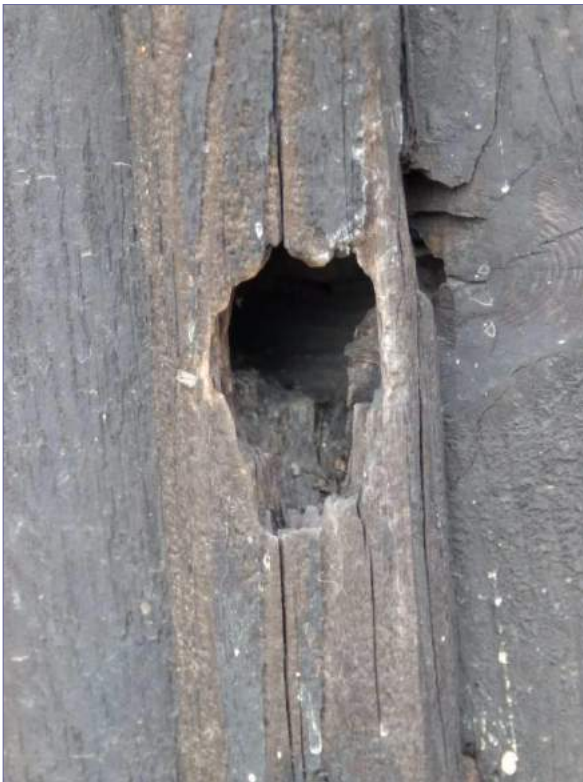
uszkodzenia dolnych fragmentów desek szalunku, wylamane listwy, zardzewiałe gwoździe kute, wyjąłowanie drewna, wyszczerbienia; widoczne otwory po owadach szkodnikach a także większe spowodowane przez gryzonie i ptaki; wypłukanie barwników, przebarwienia i spękania
