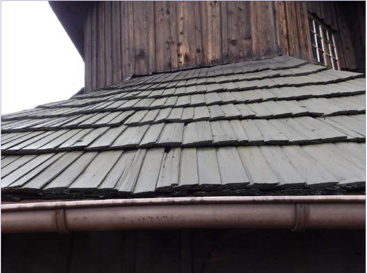
uszkodzenia gontów - spękania, ubytki, wylamanie, wypadanie deseczek
