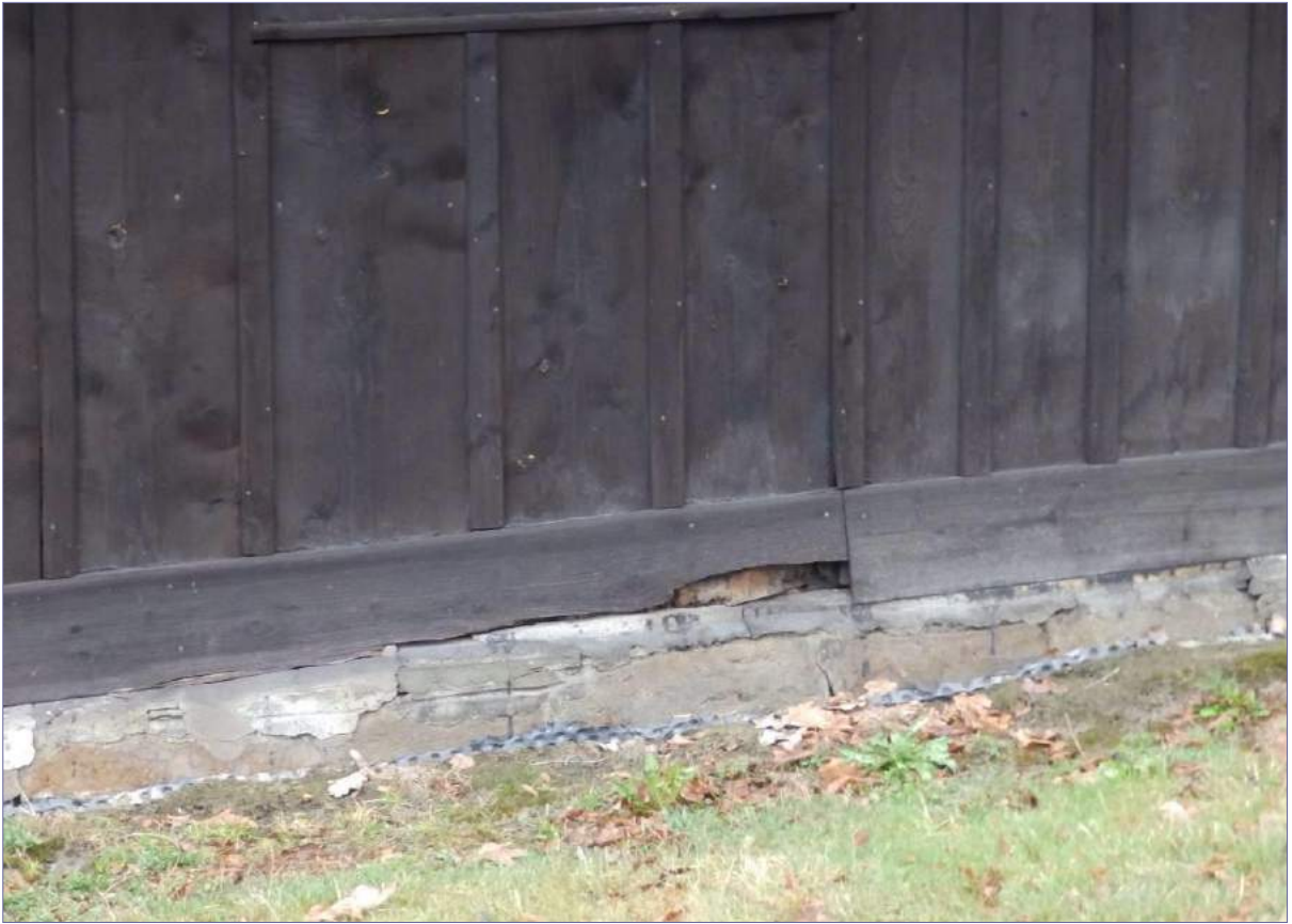
uszkodzenia deski poziomej nad podmurówką, pod spodem zniszczenia szerokich desek szalunkowych; przebarwienie, wysolenia, zgrzybienie; widoczne wystające fragmenty izolacji folii kubelkowej; zniszczenia gontu, doraźne zabezpieczenia blachą daszku, nowsze okienko kwadratowe
