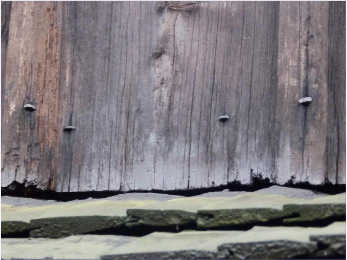
uszkodzenia dolnych fragmentów desek szalunku, wylamane listwy, zardzewiałe gwoździe kute, wyjąłowanie drewna, wyszczerbienia; widoczne otwory po owadach szkodnikach a także większe spowodowane przez gryzonie i ptaki; wypłukanie barwników, przebarwienia i spękania
