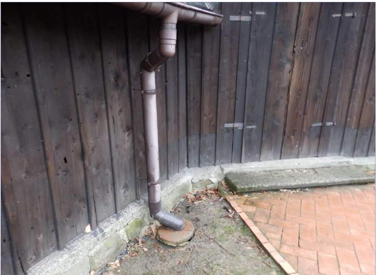
przemalowanie dolnych partii desek szalunkowych farbą w tonacji szarawej, widoczne jej złuszczenia; drzwi bez klamek i listwy przymykowej, podmurówka w górnej części zatynkowana sztywną zaprawą cementową, zniszczone rury plastikowe i rynny, odbarwienia
