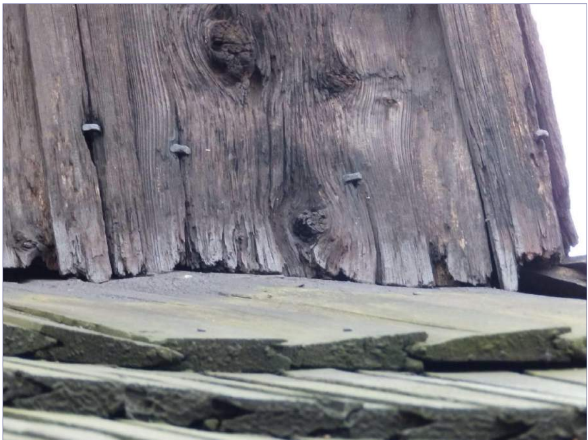
uszkodzenia dolnych fragmentów desek szalunku, wylamane listwy, zardzewiałe gwoździe kute, znaczne wyjąłowanie drewna, widoczne otwory po owadach szkodnikach, spękania i wyszczerbienia
